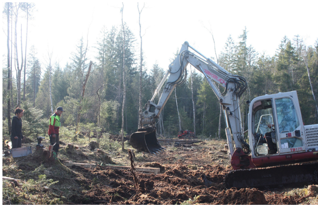
Mit Moorbagger und Know-how: Maria Schweizer und Florian Mühlegg prüfen den Sitz einer Spundwand, die Simon Mühlegg mit dem Moorbagger eingebracht hat. Foto: Frauke Ganswind
